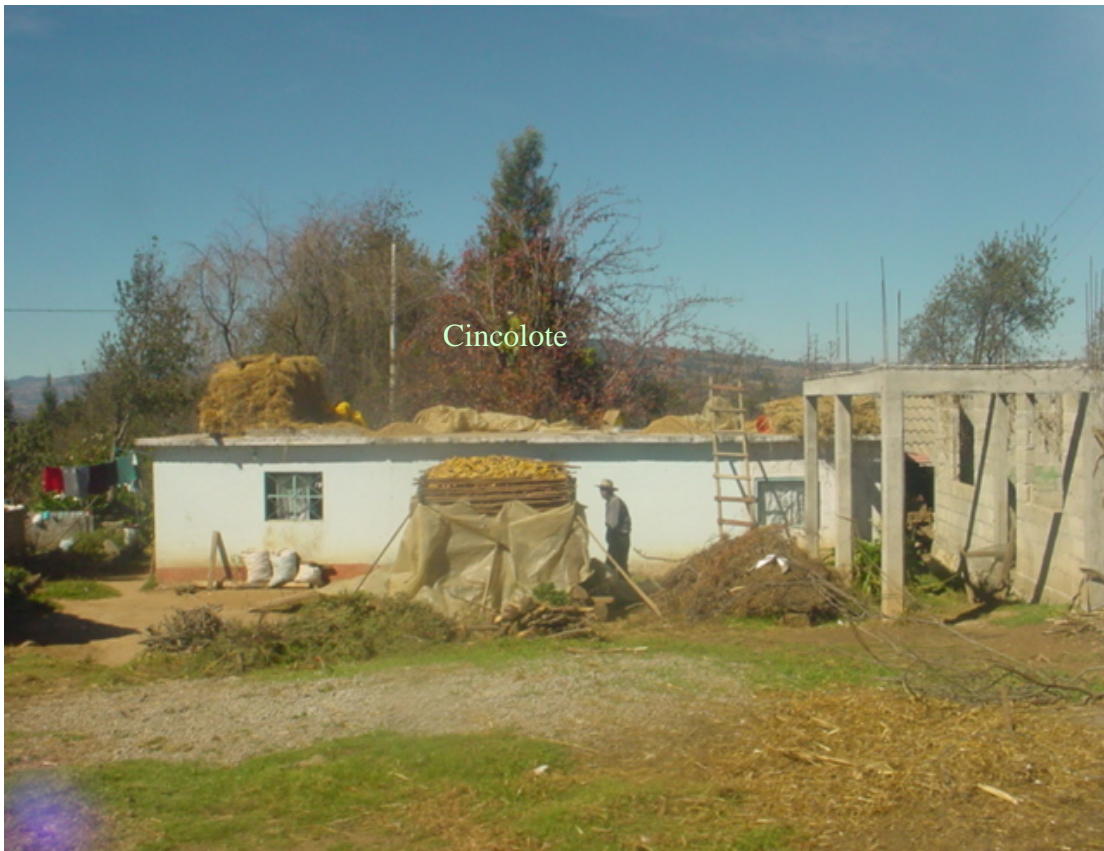
Figura 8: Presencia de cincolote
