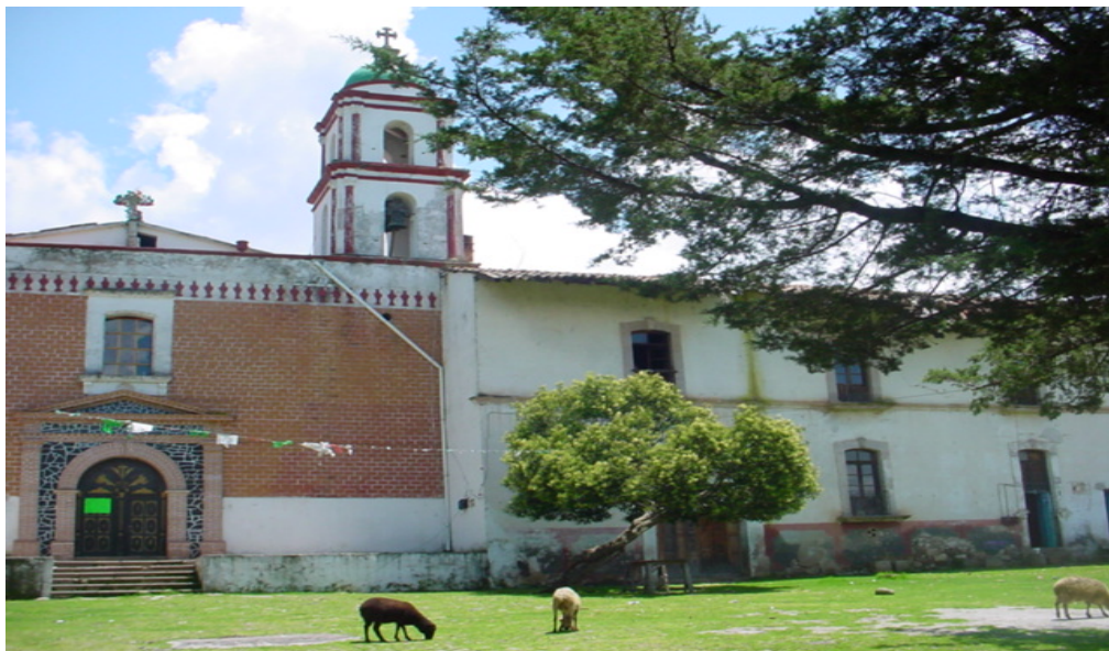
Figura 10: Fachada de la exhacienda de Ayala
