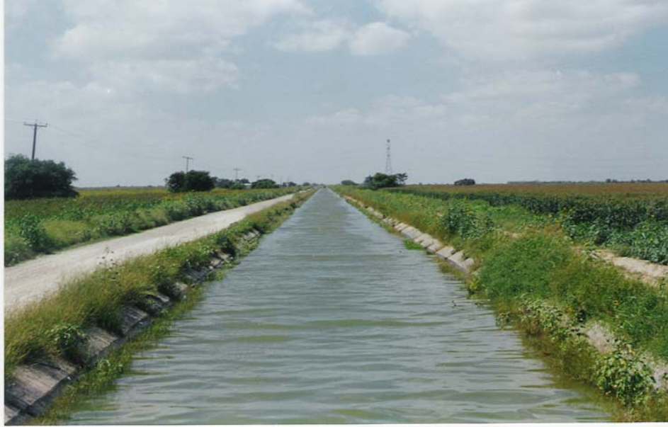
Fotografía 4. Canal secundario la obra hidráulica del Distrito de Riego 026, conocido como “la 19”.
