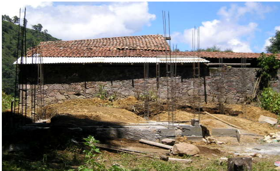
Figura N° 34 Remodelación del casco de la ex hacienda La Providencia
