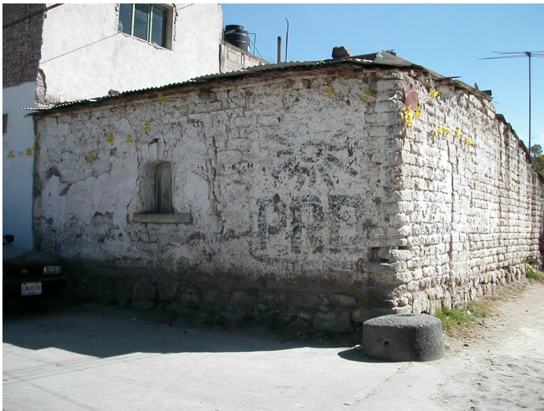
Pared de la antigua fábrica de vidrio que permanece hasta ahora. En la esquina, hay un molino que se utilizaba en esta fábrica.
