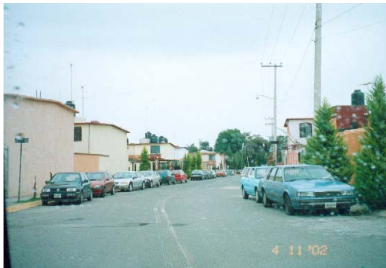
C. Habitacional Ex Hacienda de San Miguel 2ª etapa. Cuautitlán Izcalli, Estado de México.
