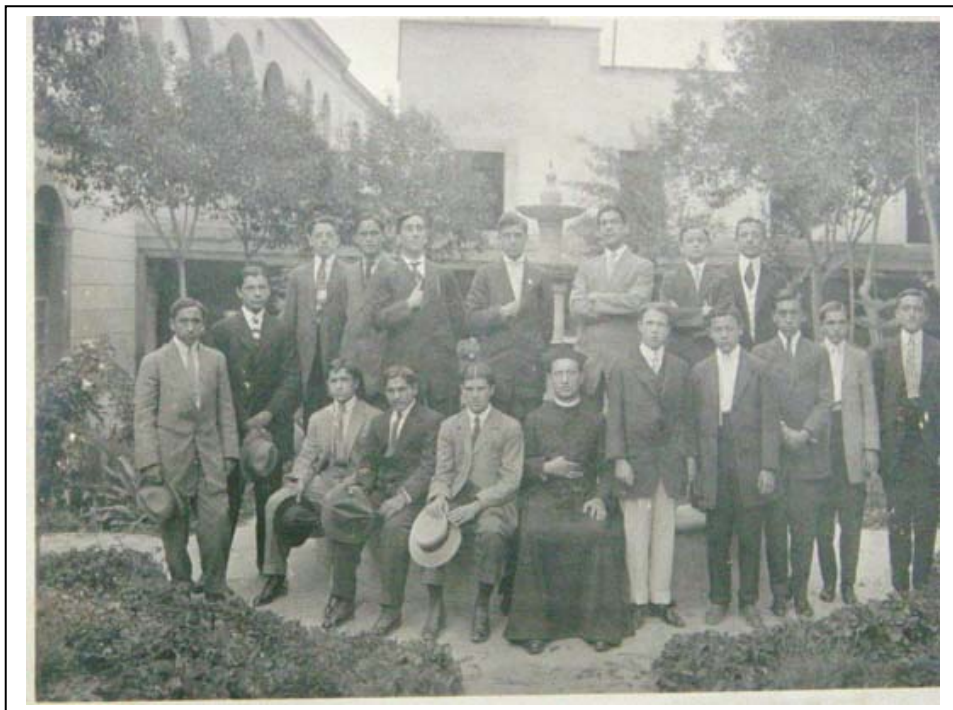
Aquí aparecen los posiblemente alumnos de la División de Mayores, con su respectivo Prefecto. En el edificio del fondo, sobre la azotea, puede haber estado el Observatorio. AHPM.
