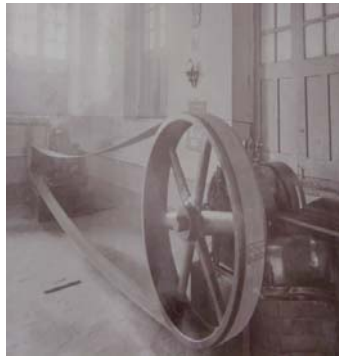
Planta que tuvo el Colegio para generar su propia energía eléctrica. AHPM.
