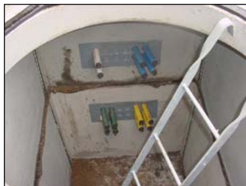
Colocación de registros eléctricos de Concreto Polimérico 2
