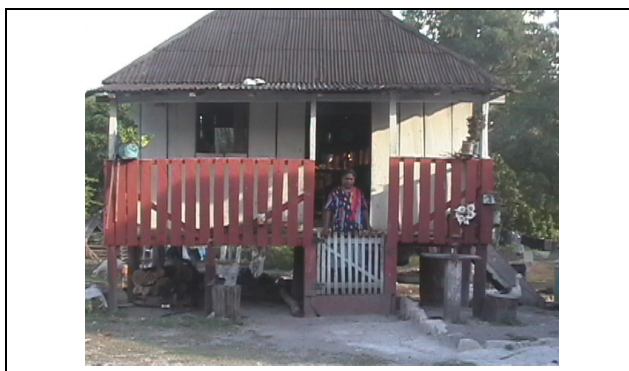
Fotografía 2.- Casas con corredor del sur de Calakmul, Campeche
