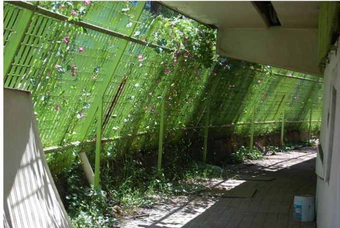
Imagen 93. El Talud ajardinado que ventila a los locales comerciales es la única vegetación existente.
