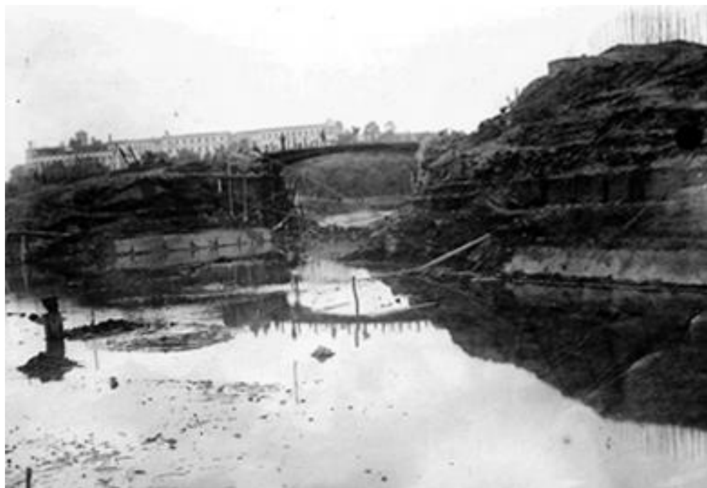
Fig. 1. Agustín Casasola, Obras de construcción del Lago de Chapultepec, ca. 1906, placa seca de gelatina, 12.7 x 17.8 cm, Fototeca Nacional INAH, 35008
