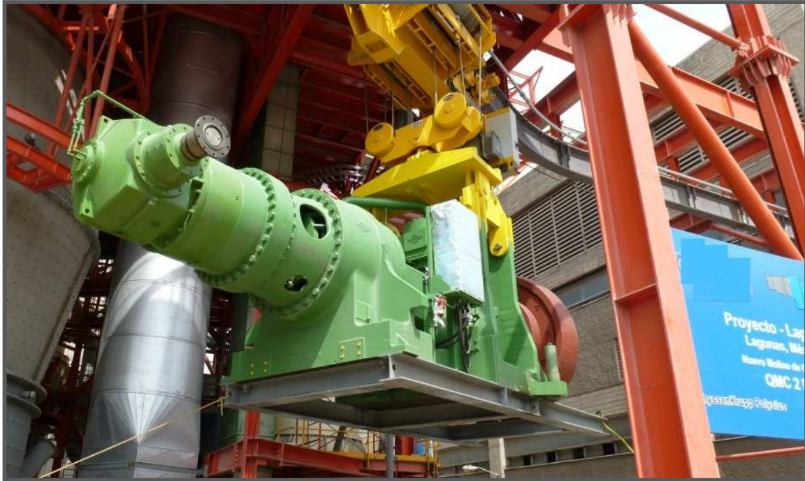
Figura 4.2.4 Caja de control que alimenta grúa de rodillos.
