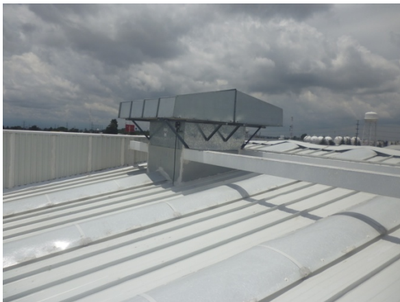
Foto 5 y 6 .- En las siguientes fotos se observa que los ventiladores instalados en la techumbre no se encuentra ajustado de manera adecuada (Tornillo y tuerca mal alineado y forzado)
