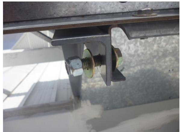
Foto 5 y 6 .- En las siguientes fotos se observa que los ventiladores instalados en la techumbre no se encuentra ajustado de manera adecuada (Tornillo y tuerca mal alineado y forzado)
