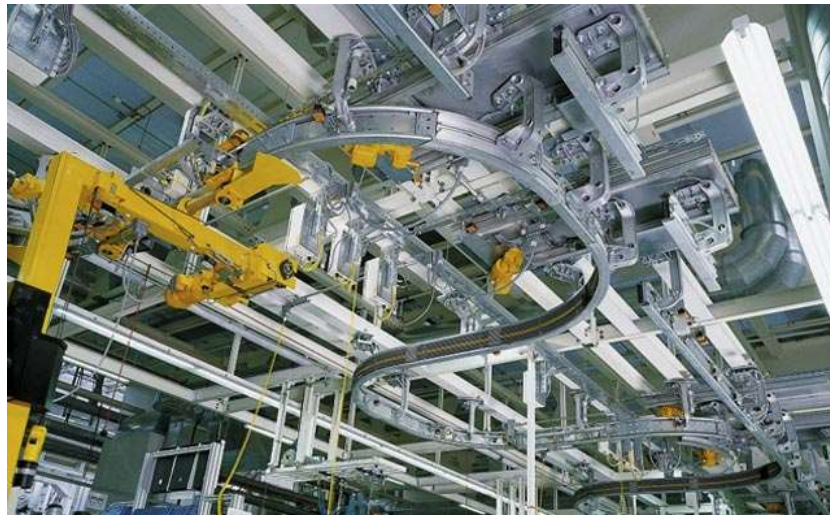
Imagen 2: Proceso automatizado. Sistema de automatización 2
