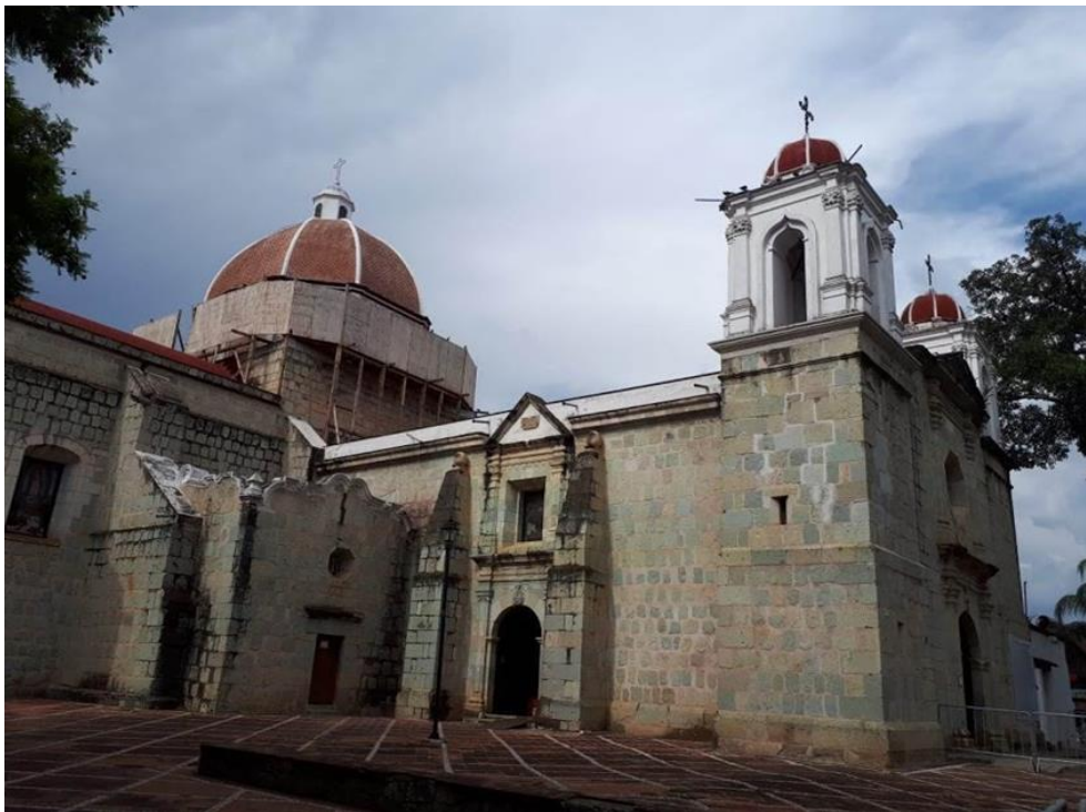
ILUSTRACIÓN 28. IGLESIA LA CUAL PERTENECIÓ AL COMPLEJO BETLEMITA DE LA CIUDAD DE ANTEQUERA, HOY OAXACA. FOTOGRAFÍA POR KARLA MEDINA MAYO 2019
