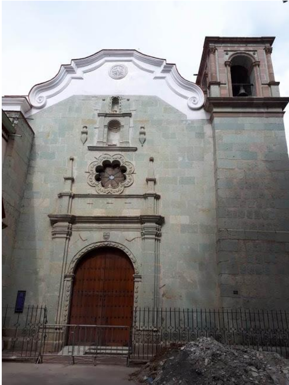
ILUSTRACIÓN 30. IGLESIA LA CUAL PERTENECIÓ AL COMPLEJO BETLEMITA DE LA CIUDAD DE ANTEQUERA, HOY OAXACA. FOTOGRAFÍA POR KARLA MEDINA MAYO 2019
