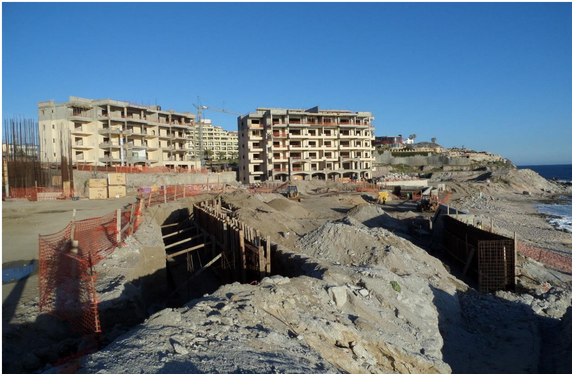
Construcción Edificio B y C
