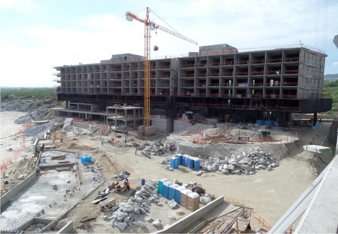
Construcción Edificio A
