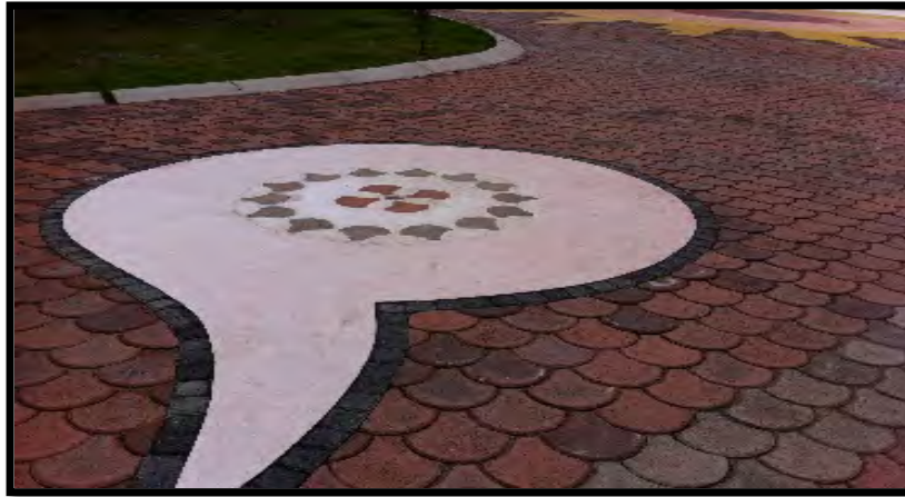
Figura 4: Signo de la lengua en los pisos de la UIEM Fuente: imagen proporcionada por el arquitecto Oscar Covarrubias
