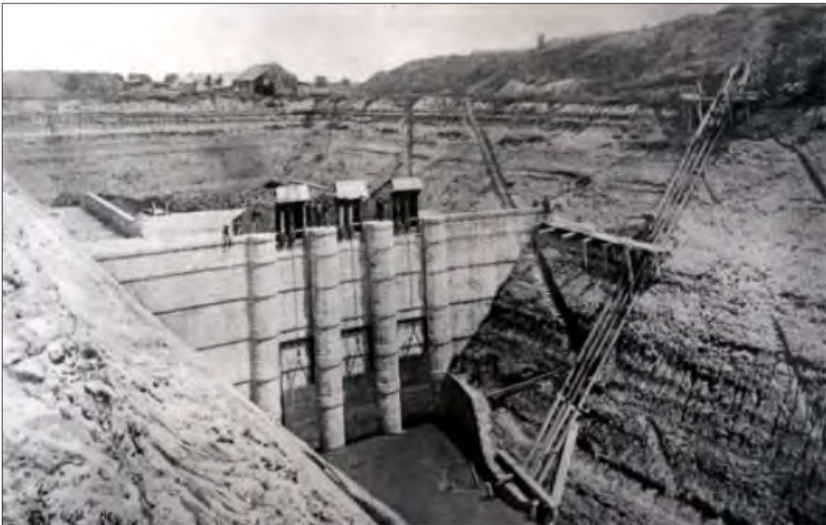
Grandes obras civiles fueron necesarias para garantizar que la capital contase con un ensanche importante, acorde con las políticas de haussmannización pretendidas. Arriba, el Gran Canal del Desagüe, con las obras en proceso; ca. 1895.
