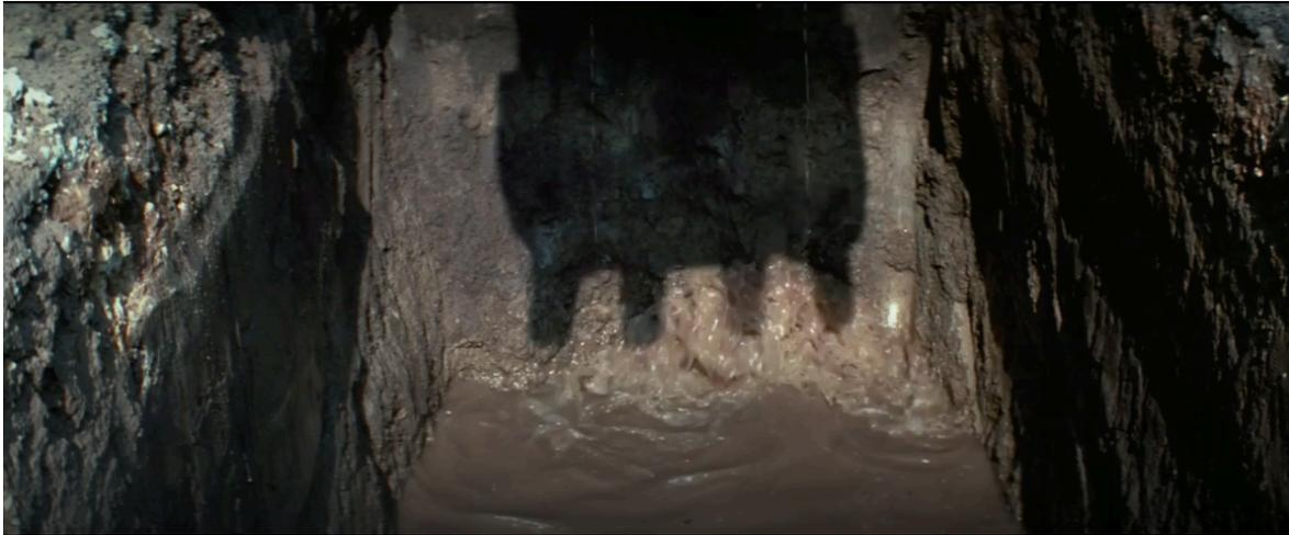
Figura 11. Agua saliendo a borbotones de la tubería rota.
