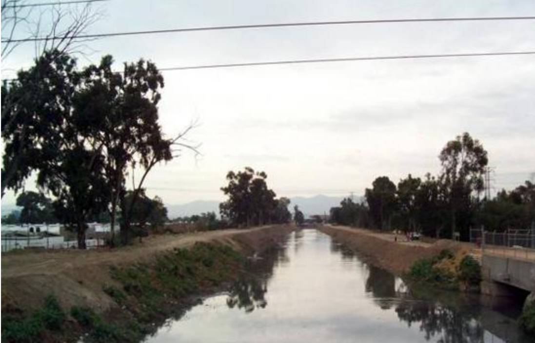
Ilustración 4-2: Canal abierto de aguas negras “Rio de los Remedios” Fuente: Documentación del proyecto
