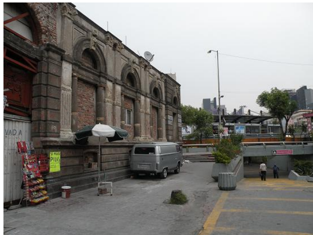
Imagen 13.- Acceso a la Glorieta por el túnel de Jalapa. La casa que se observa no está propiamente abandonada, pero sí sumamente deteriorada.
