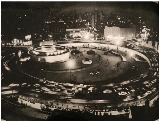
Imagen 34.- Vista aérea nocturna de la Glorieta. Imagen tomada de la Primera Memoria del Metro
