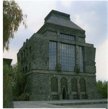
Fachada frontal del Anahuacalli
