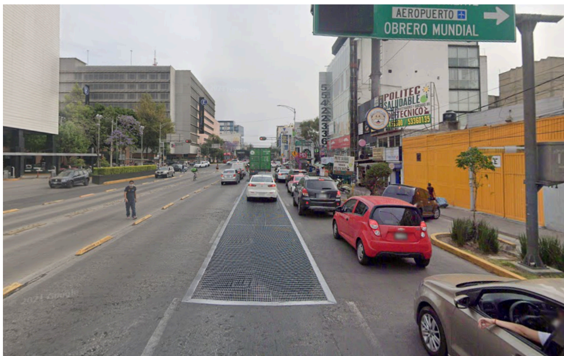
Rejillas sobre la Avenida Cuauhtémoc
